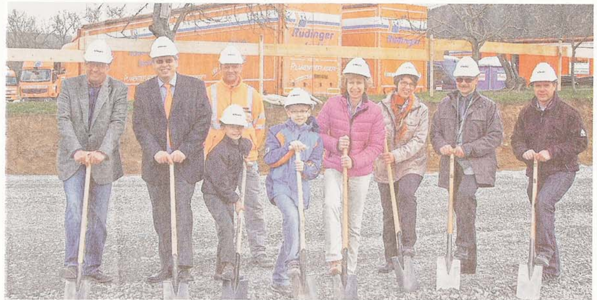
Bei Rüdinger in Altkrautheim wurde der Spatenstich für ein neues Verwaltungsgebäude gefeiert.
