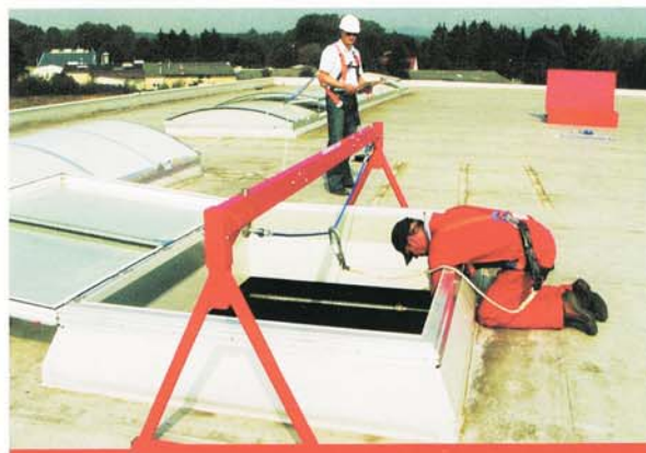
Lichtkuppeln sind empfindlich und werden am besten direkt vom Lkw herunter, ohne Zwischenlagerung, installiert
