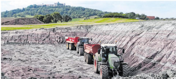
Mit dem Erdaushub haben die Arbeiten zum Bau von zwei Lagerhallen des neuen Logistikstandorts der Rüdinger Spedition in Waldenburg begonnen. Insgesamt sollen dort zwölf Hallen entstehen.
