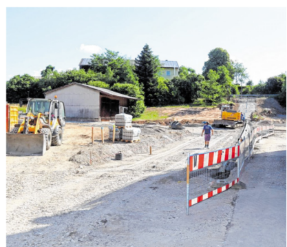
In Bofsheim laufen derzeit Maßnahmen zur Dorfentwicklung. In der Brückenstraße entstehen vier Bauplätze. BILD: HELMUT FRODL
